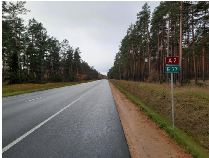
Valsts galvenais autoceļš A2 posmā starp Garkalni un Vangažiem
