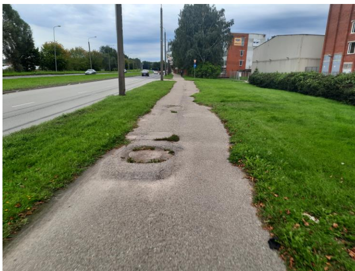
Ietve Mūkusalas ielā
