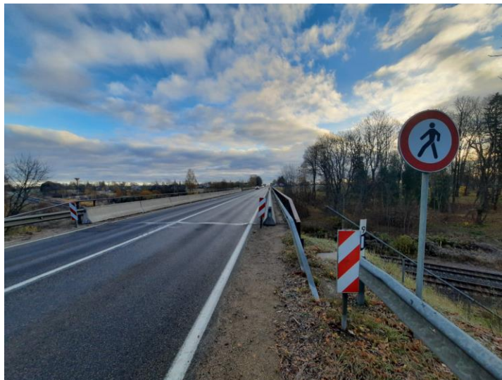
Autoceļa A2 pārvads pār dzelzeļa līniju "Rīga – Lugaži"
