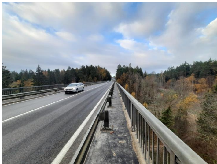
Autoceļa A2 viadukts pār Lorupes gravu
