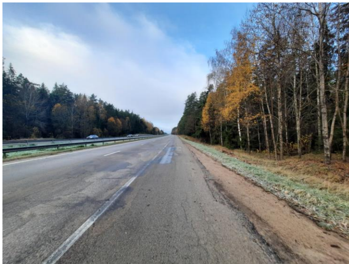
Autoceļš A2 posmā no "Sēnītes" līdz Siguldai
