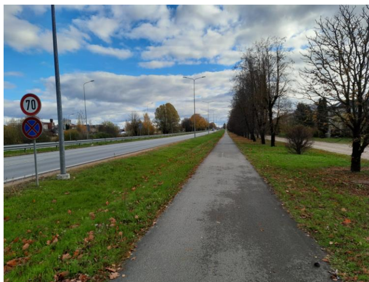
Kopīgs gājēju un velosipēdu ceļš gar autoceļu A6 Ogrē
