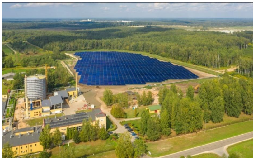
P6.5. attēls – saules kolektoru sistēmas uzstādīšana Salaspilī
