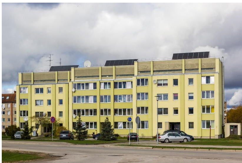
P.6.4. attēls – saules kolektora uzstādīšana uz daudzdzīvokļu mājas Siguldā
