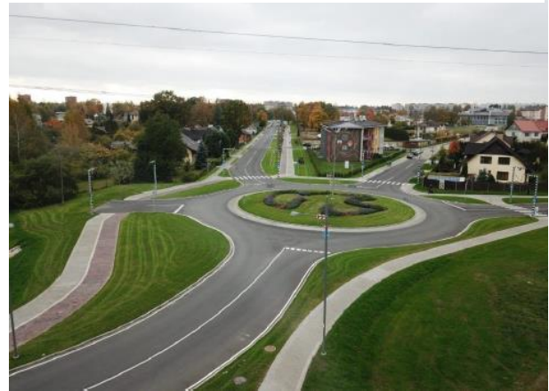
Attēls 22 Lauku ielas rotācijas aplis Salaspilī, 2018
