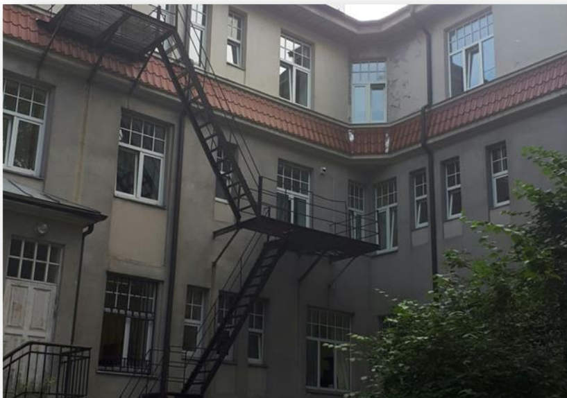
Att. Nr. 4 filiāles “Rīga” vēsturiskā ēka (Avots – Ēkas apsekojamā laikā uzņemtie attēli)
