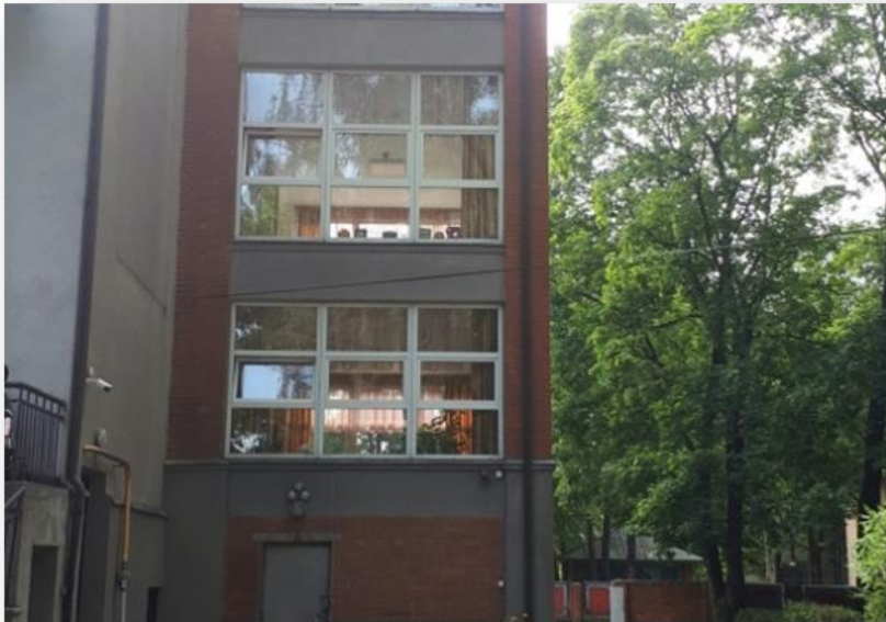
Att. Nr. 5 filiāles “Rīga” vēsturiskā ēka (Avots – Ēkas apsekojamā laikā uzņemtie attēli)
