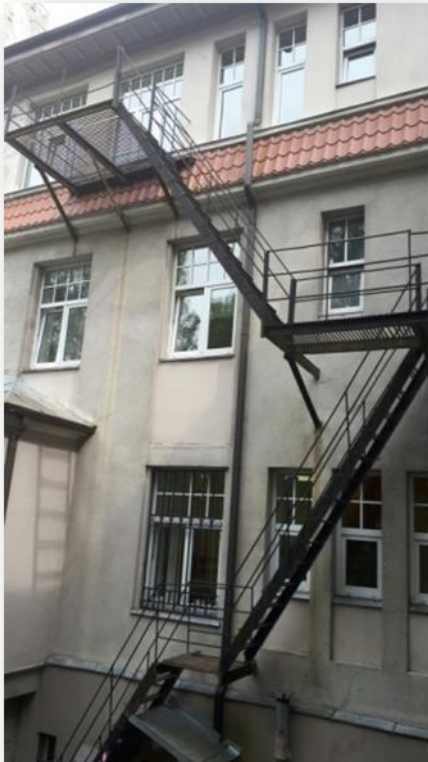
Att. Nr.3 filiāles “Rīga” vēsturiskā ēka (Avots – Ēkas apsekojamā laikā uzņemtie attēli)
