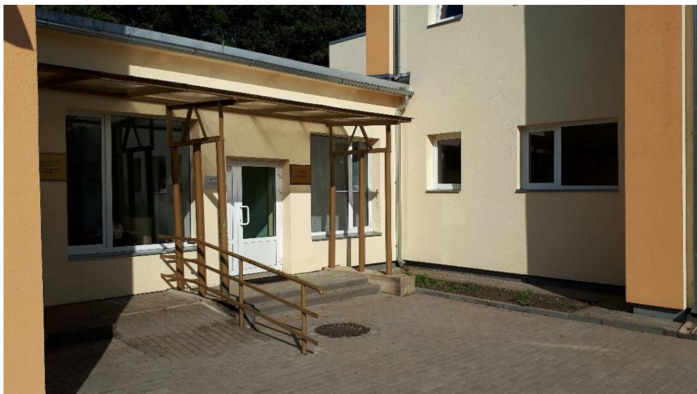
Att. Nr. 12. Ēkas ārējā fasāde
