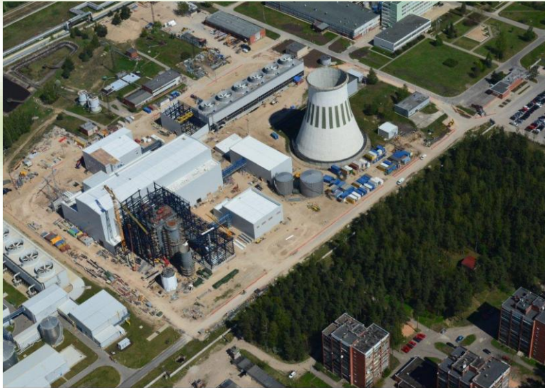
Attēls 1. Jaunā energobloka būvlaukumā Rīgas TEC-2 2011./2012.gadā. Avots: AS „Latvenergo”
